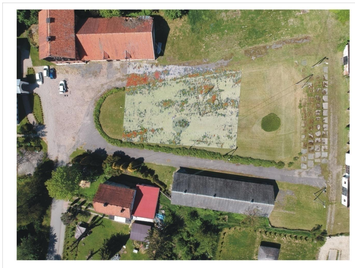
Ryc. 21. Lokalizacja poligonu oraz wyniki profilowań GPR w obrębie poligonu 1A (Welc 2020)
