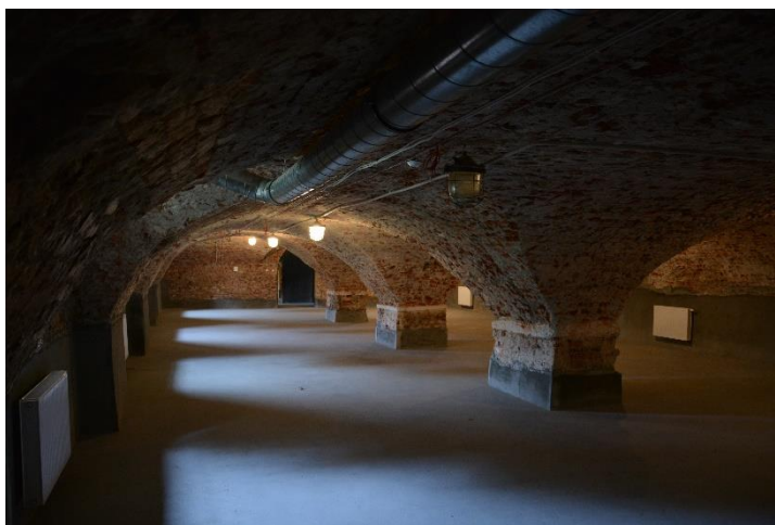
2 – Remontowane pomieszczenia skrzydła południowego
